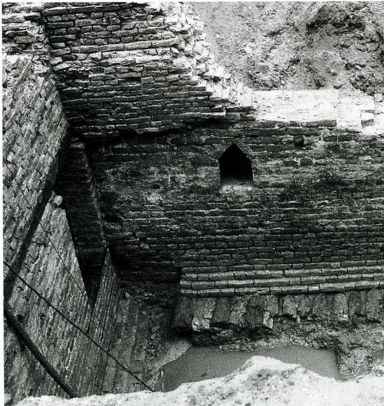
Figuur 14: Fundering van de oostelijke muur van Huis Scharlaken (DOR 3). De muur heeft een verbrede muurvoet en rust op dwarsgelegde kortelingen (Sarfatij 2007, 205).
