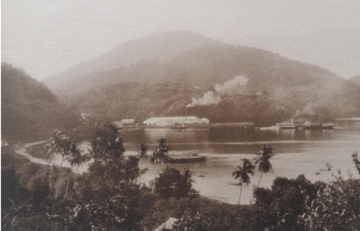
Figuur 11: Gezicht op de Sabangbaai met de ReT fabriek op de achtergrond. Bron: De Boer, Zeehaven en Kolenstation Sabang, p. 45.
