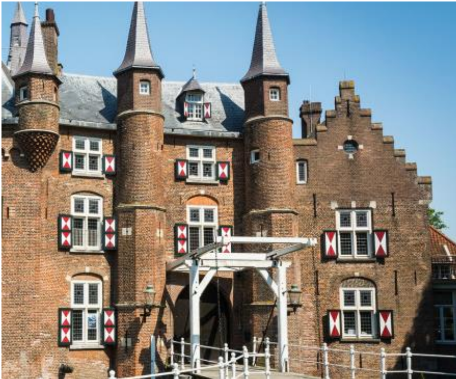
4.10. Detail van kasteel Maurick. Fotograaf onbekend. Foto genomen vanuit het zuiden.
