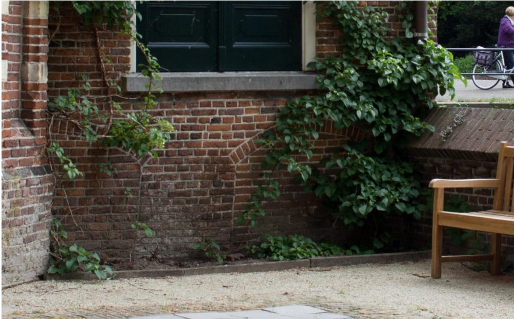
3.20. Dichtgemetselde kelderramen van Maurick . H. Splinter (2016). Foto genomen vanuit het westen.
