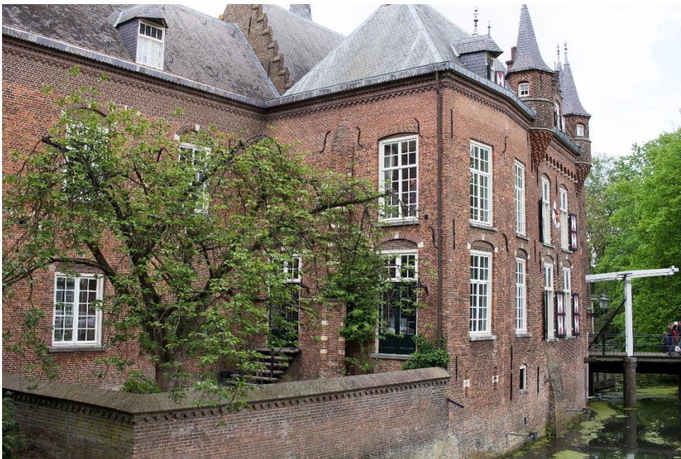
4.16. Patio van kasteel Maurick . H. Splinter (2016). Foto genomen vanuit het zuidwesten.
