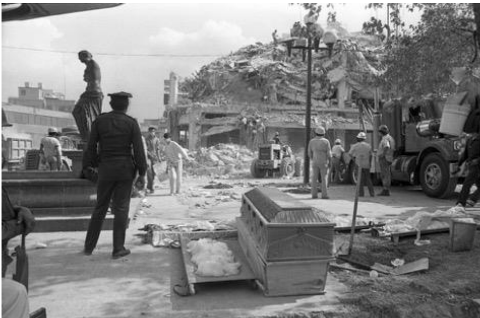
Foto 2: Edificio destruido por el terremoto de 1985 en Insurgentes y Álvaro Obregón (Colonia Roma). Foto: Pedro Valtierra/El País (España)
