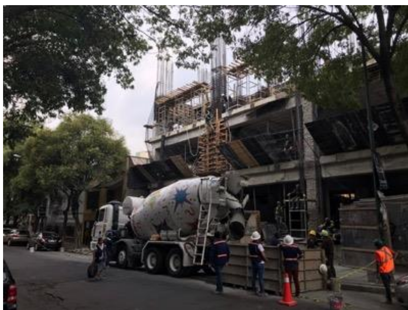
Foto 6: Un edificio en construcción, Calle Zacatecas, Colonia Roma. Foto: José Baig
