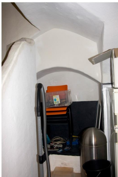
Een nis of een oude doorgang? De verhoging is een mogelijke aanwijzing voor het verdiepen van de kelder
