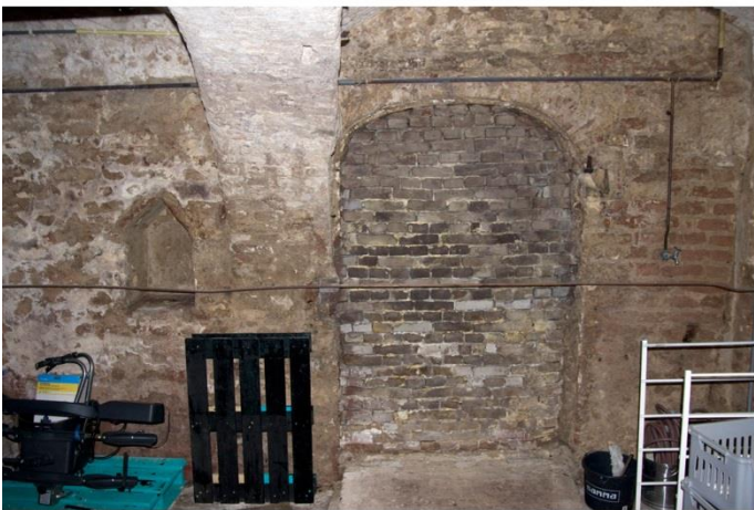
Dichtgezette doorgang naar een voormalige naastgelegen kelder
