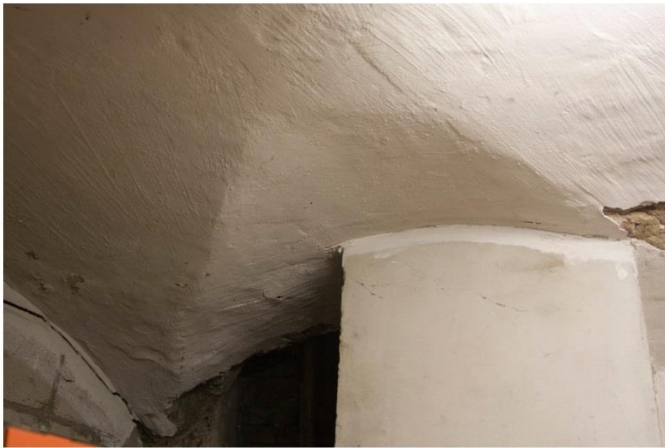
Van de oude toegang rest alleen nog deze steekkap.
