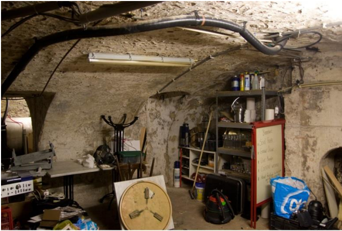
Tongewelf voorkelder met twee doorgangen naar de achterkelder, rechts is de haardplaats zichtbaar
