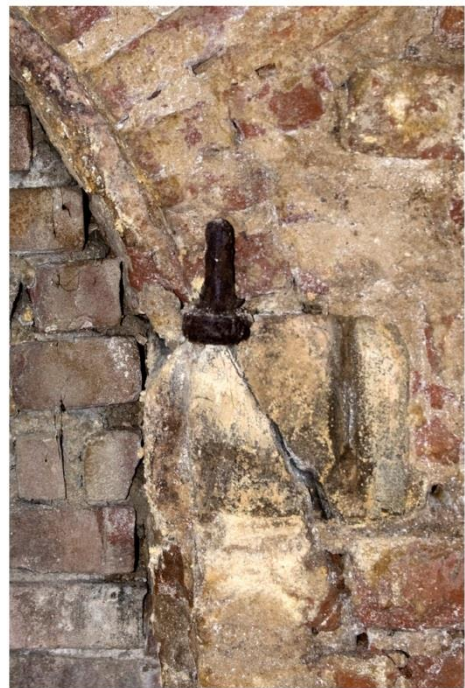
Bovenste scharnierpunt naast de dichtgezette doorgang, rustend op een blok natuursteen
