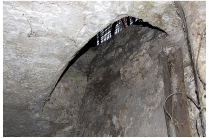
Kelderlicht aan de straatzijde
