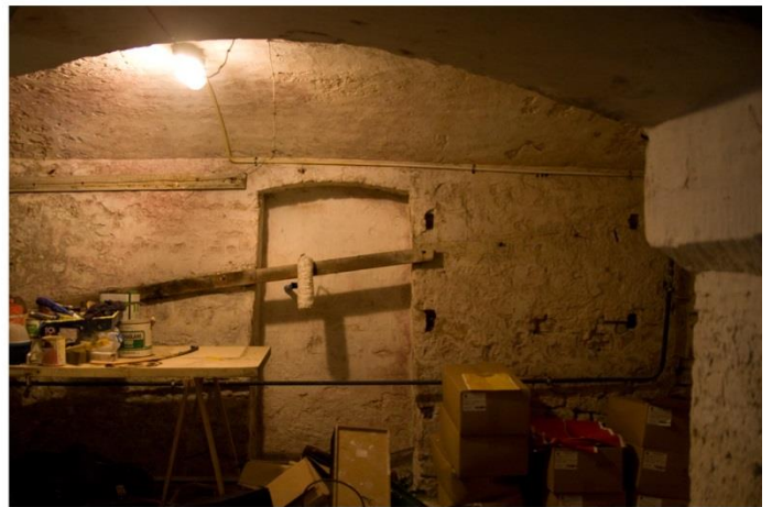
Dichtgezette doorgang naar naastgelegen kelder
