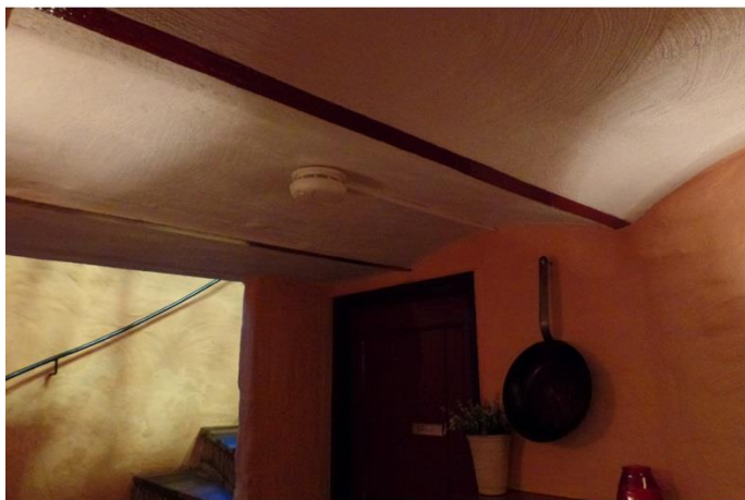
Troggewelf met staalbalken
