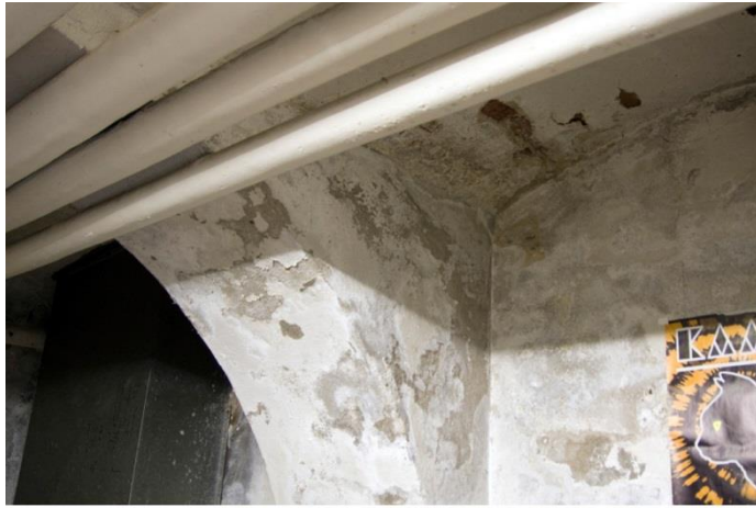
Troggewelven met gordelbogen (grote kelder)
