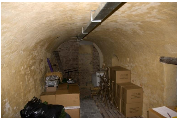
Overzichtsfoto richting achterzijde, in de achterwand is een (dichtgezette) stortkoker zichtbaar
