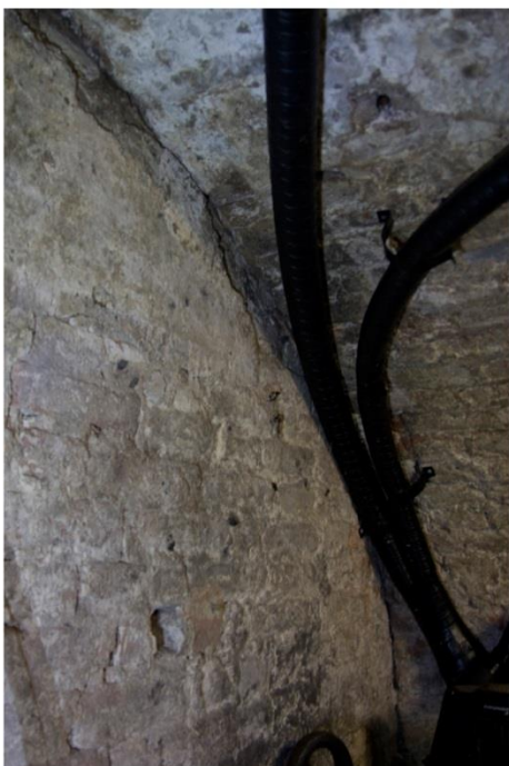
Een koude naad tussen tongewelf en zijmuur is een aanwijzing dat het tongewelf mogelijk pas later is toegevoegd
