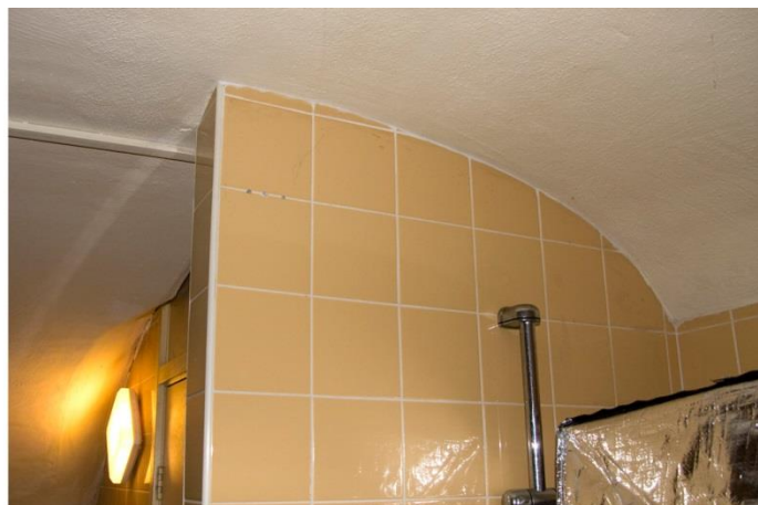
Het kwartongewelf aan de straatzijde wijst op een kelder van het Zutphense type, links is nog een aanzet zichtbaar van een mogelijke toegang
