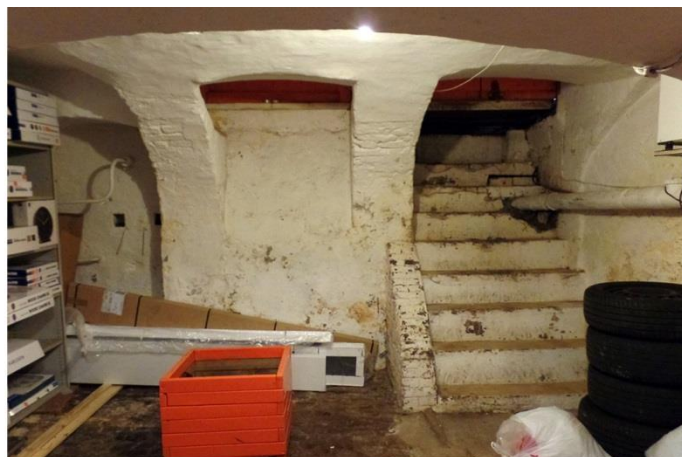
Keldertoegang aan de straatzijde
