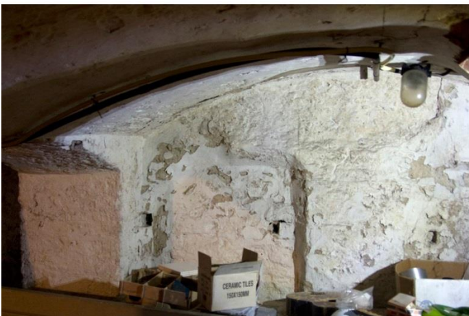
Mogelijke oude doorgang in achterwand
