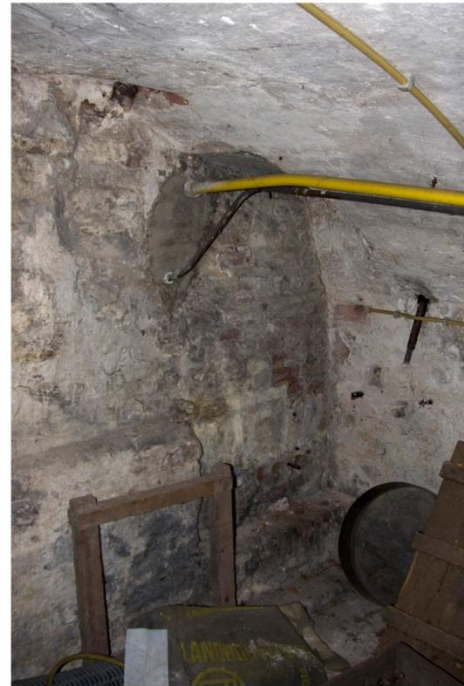
Dichtgezette keldertoegang naar de straatzijde op exact dezelfde plek, als de nog functionerende in de naastgelegen kelder onder Papenstraat 17
