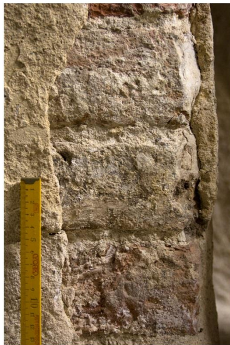
Detail bakstenen van de gemetselde gordelboog
