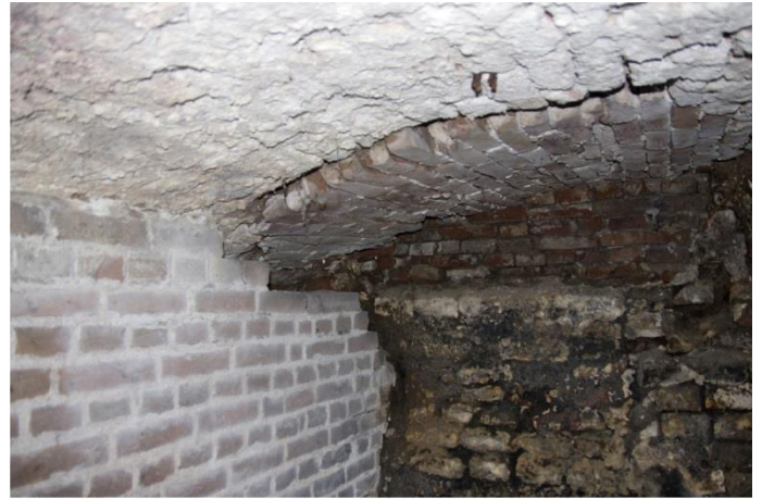
Verschillende fasen muurwerk in de kleine kelder
