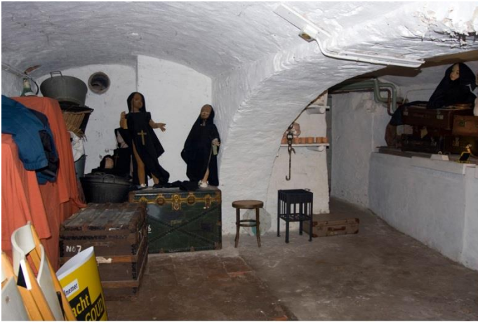
Overzichtsfoto van de grote kelder vanaf de straatkant genomen, zichtbaar zijn de troggewelven en gordelboog en de pekelbakken uiterst rechts
