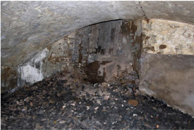
Stortkoker in de achterwand, in het verleden gebruikt voor het storten van steenkool in de kelder
