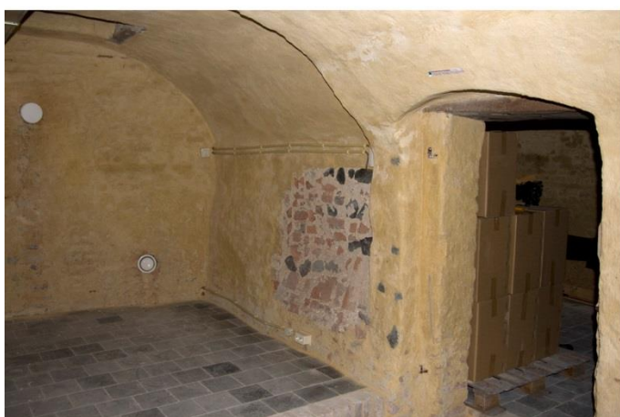
Doorgang naar naastgelegen kelder, in het muurwerk zijn leisteenfragmenten zichtbaar
