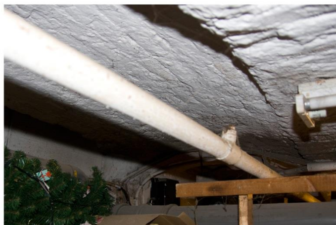
Troggewelf aan de straatzijde, haaks op het tongewelf. Mogelijk om de toegang te vergemakkelijken, zoals bij het Zutphense type
