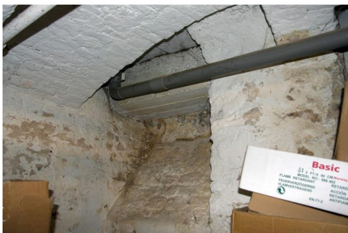
Dichtgezette oorspronkelijke toegang aan de straatzijde
