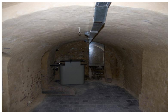
Overzichtsfoto richting achterzijde, in de achterwand is de oude doorgang met trap zichtbaar
