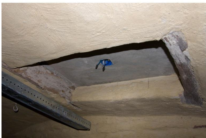
Een voormalig luik met houten omlijsting?
