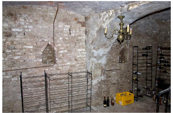
Troggewelven met gordelboog en lichtnissen met keperboog
