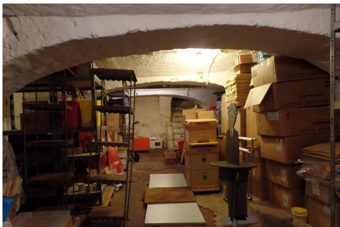
Troggewelven met gordelbogen gezien richting straatzijde
