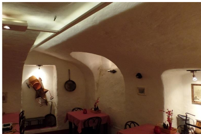
Kelder van het Zutphense type, met een kwart tongewelf aan de straatzijde
