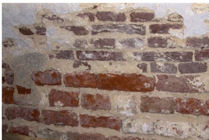
Verschillende baksteenformaten in het muurwerk, de bovenste helft is het gewelf, de onderste helft de zijmuur
