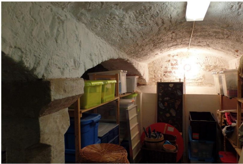
Troggewelven met gordelbogen steunend op zuilen van Bentheimer zandsteen
