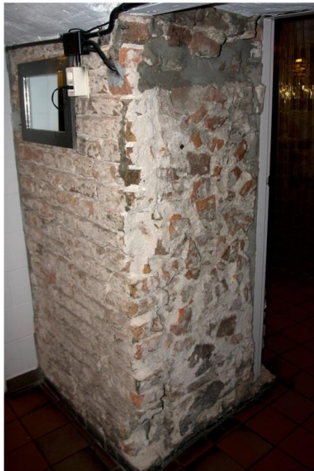
Muurwerk met een dikte van 94 cm
