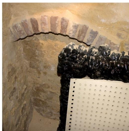
Dichtgezette doorgang met segmentboog
