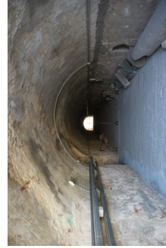
hoofdtunnel van de kelderdoorgang
