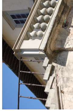
gedetailleerde restauratie van de trappen
