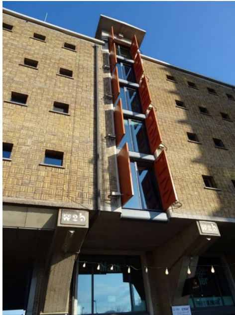
Afb. 130. Jan de Bie Leuveling Tjeenk, Pakhuis De Zwijger , Oostelijke Handelskade 16, Amsterdam, 1934. Gezicht op de voorgevel vanuit het zuiden. Detail. Reeks laaddeuren.
