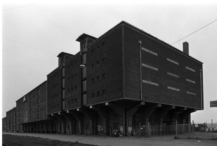
Afb. 126. Jan de Bie Leuveling Tjeenk, Pakhuis De Zwijger , Oostelijke Handelskade 16, Amsterdam, 1934. Gezicht op de zijgevel vanuit het oosten.
