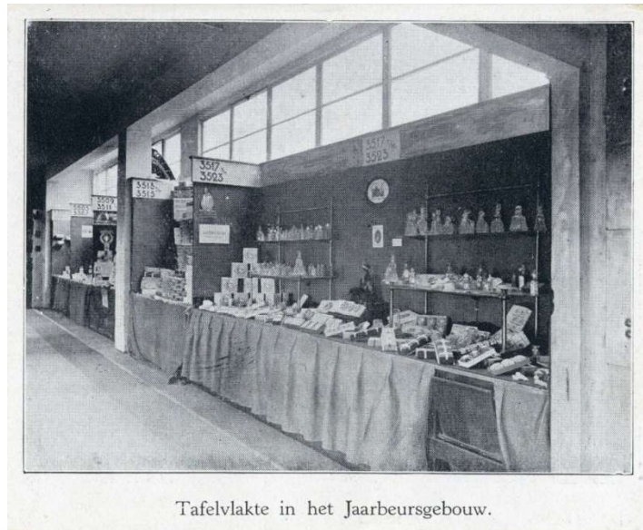
Afb. 71. Jan de Bie Leuveling Tjeenk en Michiel Brinkman, Het eerste Jaarbeursgebouw , Utrecht, 1921. Gezicht op de tafelvlakte op de derde verdieping.
