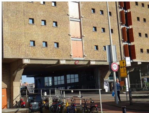
Afb. 132. Jan de Bie Leuveling Tjeenk, Pakhuis De Zwijger , Oostelijke Handelskade 16, Amsterdam, 1934. Gezicht op de voorgevel vanuit het zuiden met brug.
