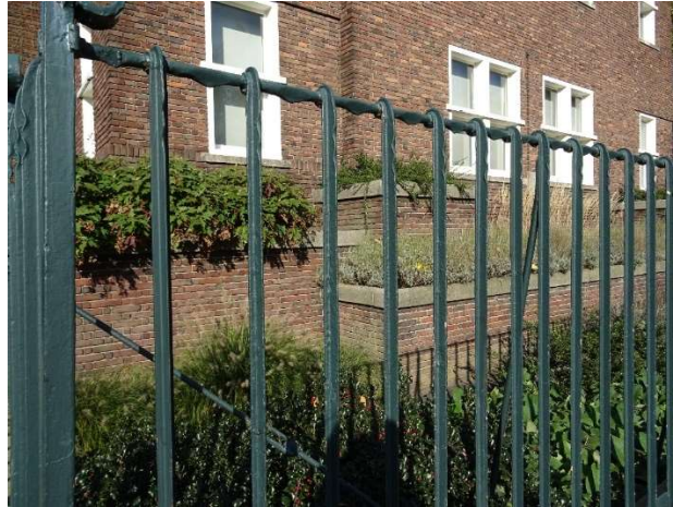
Afb. 86. Jan de Bie Leuveling Tjeenk, Villa Museumplein , Museumplein 4, Amsterdam. Detail. Gezicht op de voorgevel met plantenbakken.
