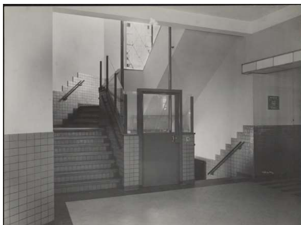
Afb. 117. Jan de Bie Leuveling Tjeenk, Kantoorgebouw Koninklijke Fabriek F.W. Braat , Hooikade 13, Delft, 1930. Trappenhuis.
