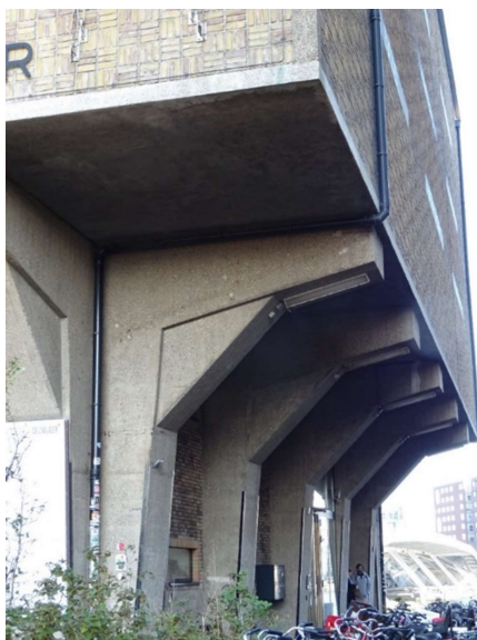
Afb. 124. Jan de Bie Leuveling Tjeenk, Pakhuis De Zwijger , Oostelijke Handelskade 16, Amsterdam, 1934. Gezicht op de voorgevel vanuit het zuiden. Detail. Betonnen colonnes.
