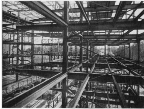
Het ijeren geraamte van het derde jaarbeursgebouw te Utrecht.
