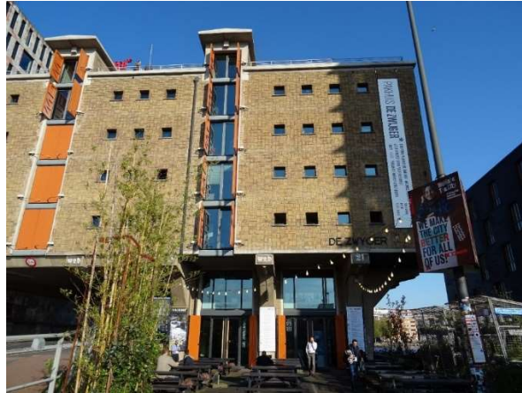
Afb. 133. Jan de Bie Leuveling Tjeenk, Pakhuis De Zwijger , Oostelijke Handelskade 16, Amsterdam, 1934. Gezicht op de voorgevel vanuit het zuiden met café op de begane grond.
