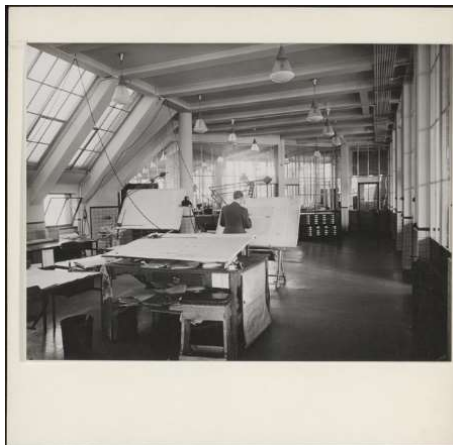
Afb. 122. Jan de Bie Leuveling Tjeenk, Kantoorgebouw Koninklijke Fabriek F.W. Braat , Hooikade 13, Delft, 1930. Tekenkamer op de tweede verdieping.
