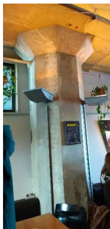
Afb. 129. Jan de Bie Leuveling Tjeenk, Pakhuis De Zwijger , Oostelijke Handelskade 16, Amsterdam, 1934. Begane grond. Detail van de betonnen colonne van de paddestoelvloeren.
