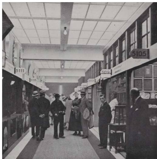
Afb. 84. Jan de Bie Leuveling Tjeenk, Het Tweede jaarbeursgebouw , Utrecht, 1931. Gezicht op de monsterkamers op de vijfde verdieping.
