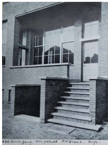
Afb. 110. Jan de Bie Leuveling Tjeenk, Kantoorgebouw Koninklijke Fabriek F.W. Braat , Hooikade 13, Delft, 1930. Gezicht op de achtergevel vanuit het noorden.
