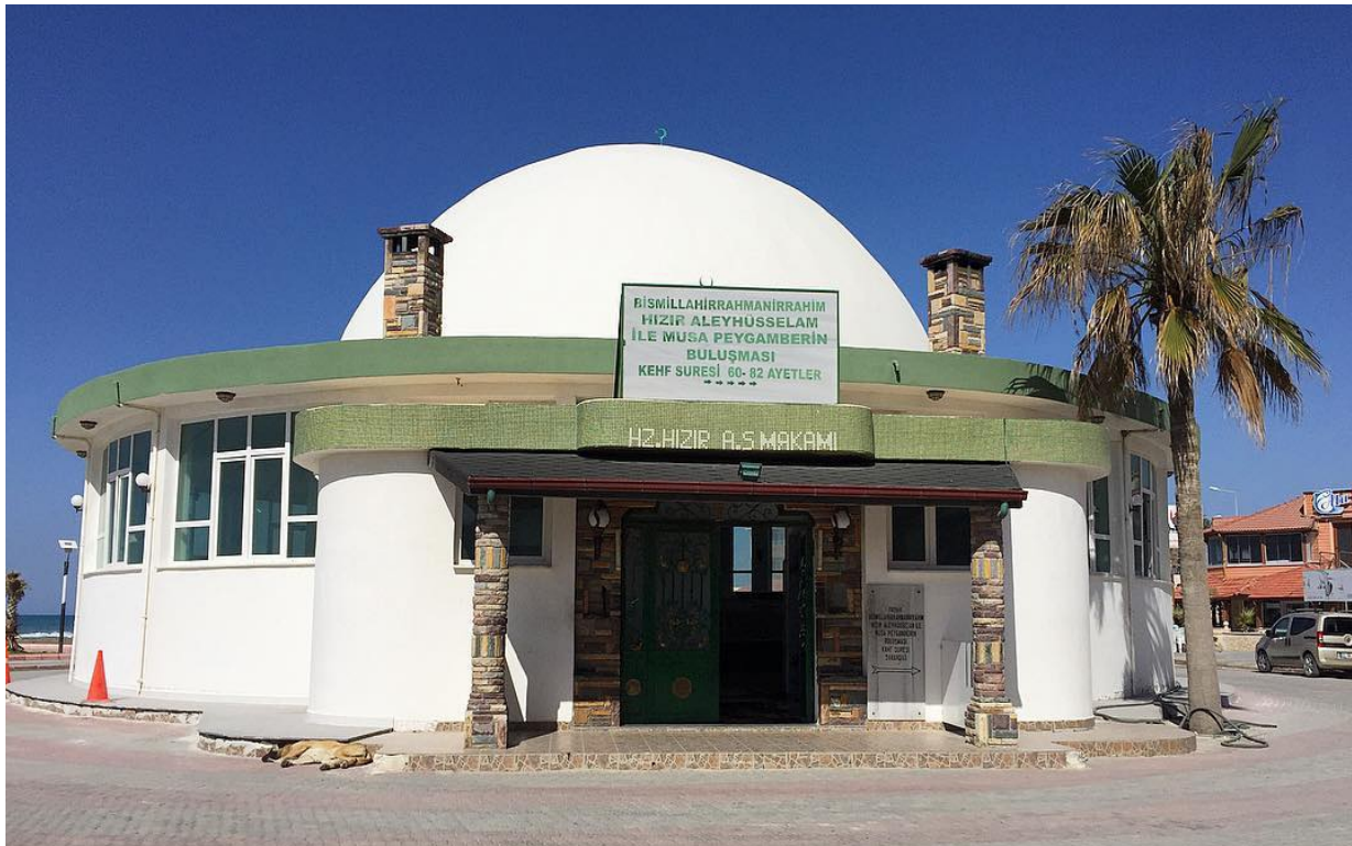
Illustration 12: The Hazreti Hızır Makamı after the latest renovations.
