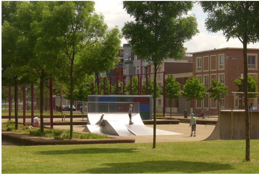
Het Kaappark met op de achtergrond de vrije kavelwoningen. 92
