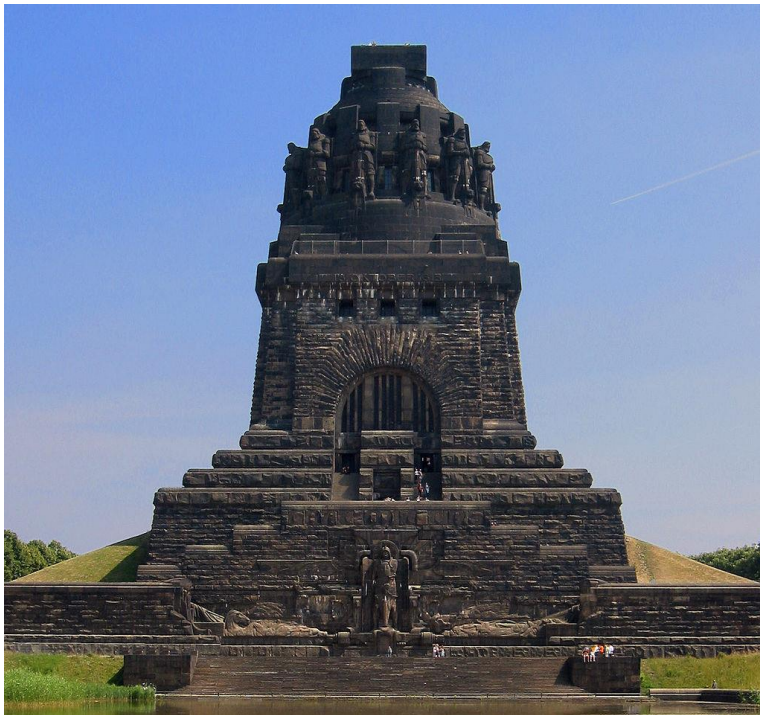
Schmitz, Bruno. Völkerschlachtdenkmal (monument to the battle of the Nations), 1913, concrete and granite, (Leipzig, Strasse des 18. Oktober 100).
