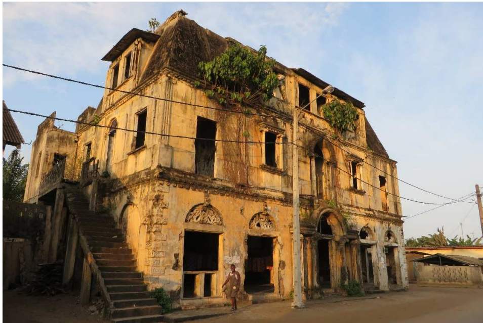
Photographie 11 : Bâtiment Ganamet Photographie de M. Duflos
